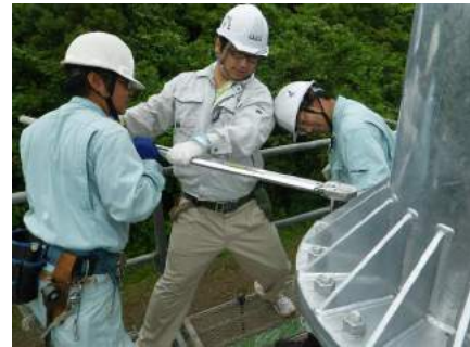
防災無線鉄柱の据付工事
