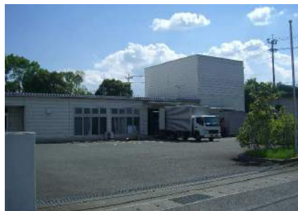
パクス本社工場（佐賀県鳥栖市）
