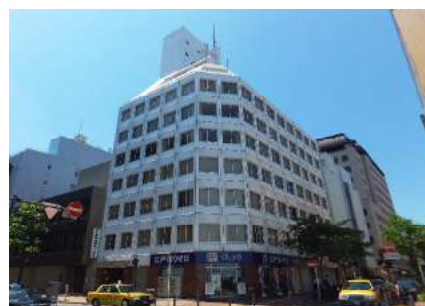
エナジー・ソリューションズ（横浜市中区）
