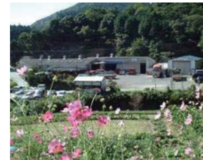
リサイクルセンター外観
